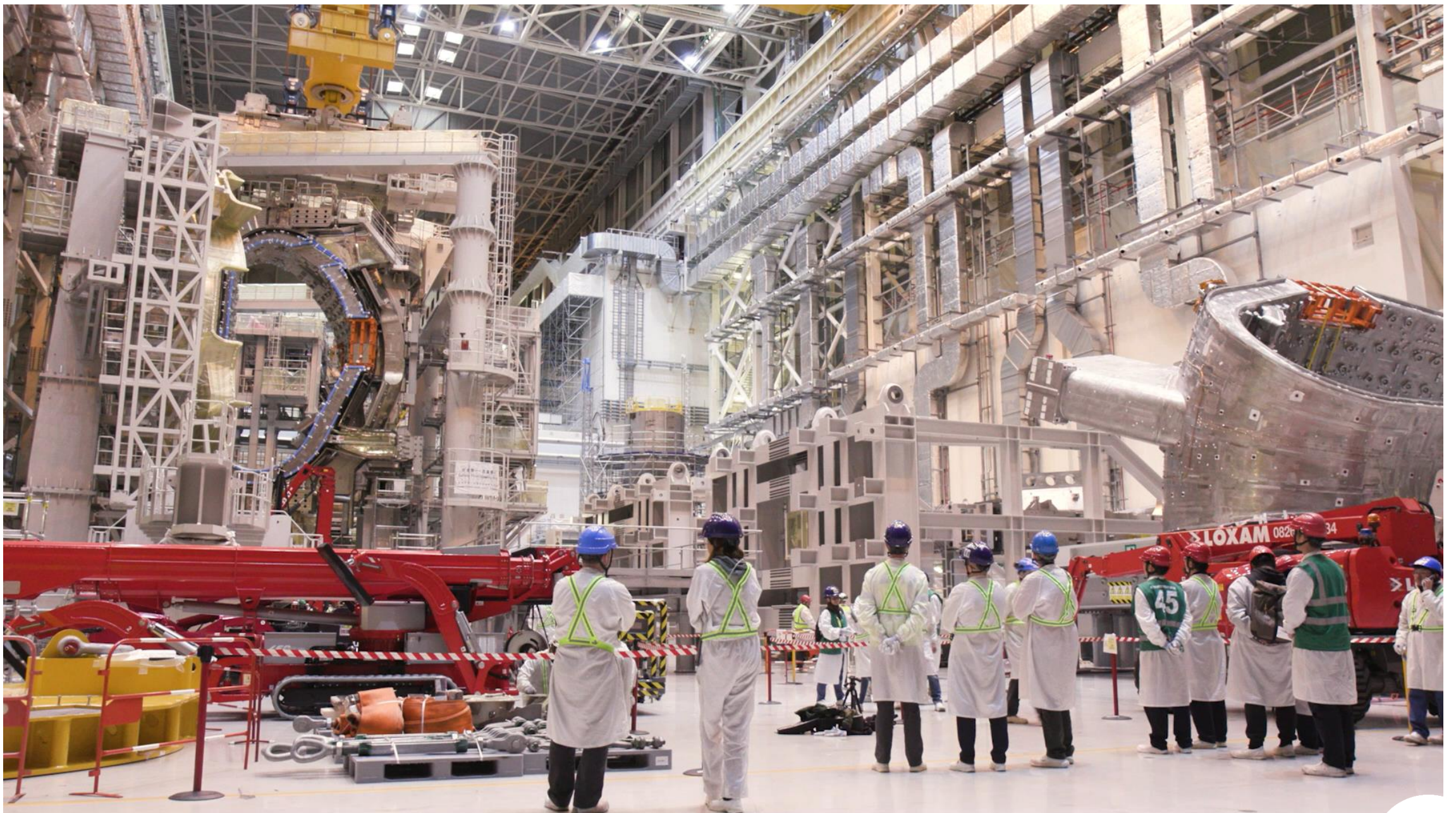
Installation du troisième module de secteur (n°5) le 24 novembre 2025. Le quatrième secteur a été déplacé dans le puits le 28 janvier 2026.
