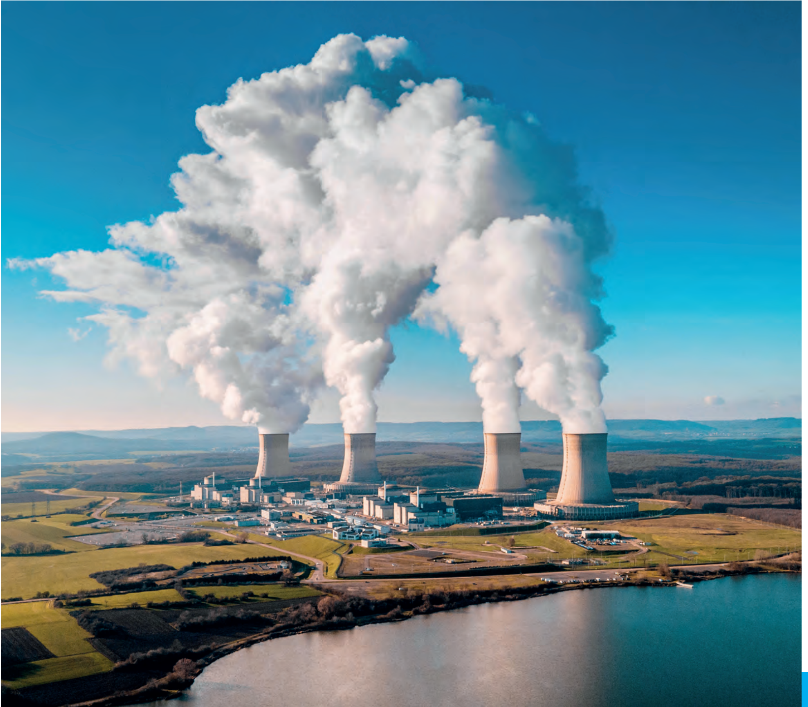
Centrale de Cattenom
