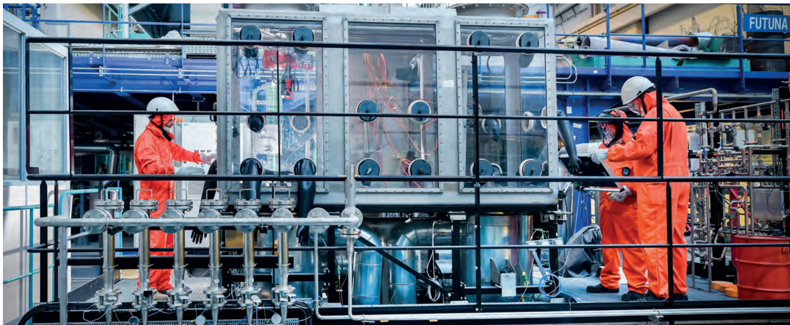
CEA Cadarache - Boucle d'essai sodium
