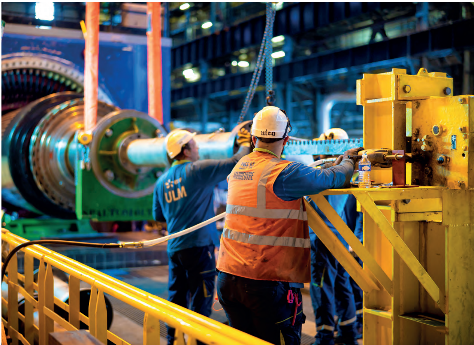
Centrale de Cattenom - Introduction d'un rotor d'alternateur par l'ULM
