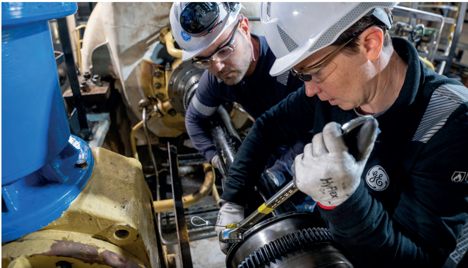
Centrale de Civaux - Travaux en salle des machines
