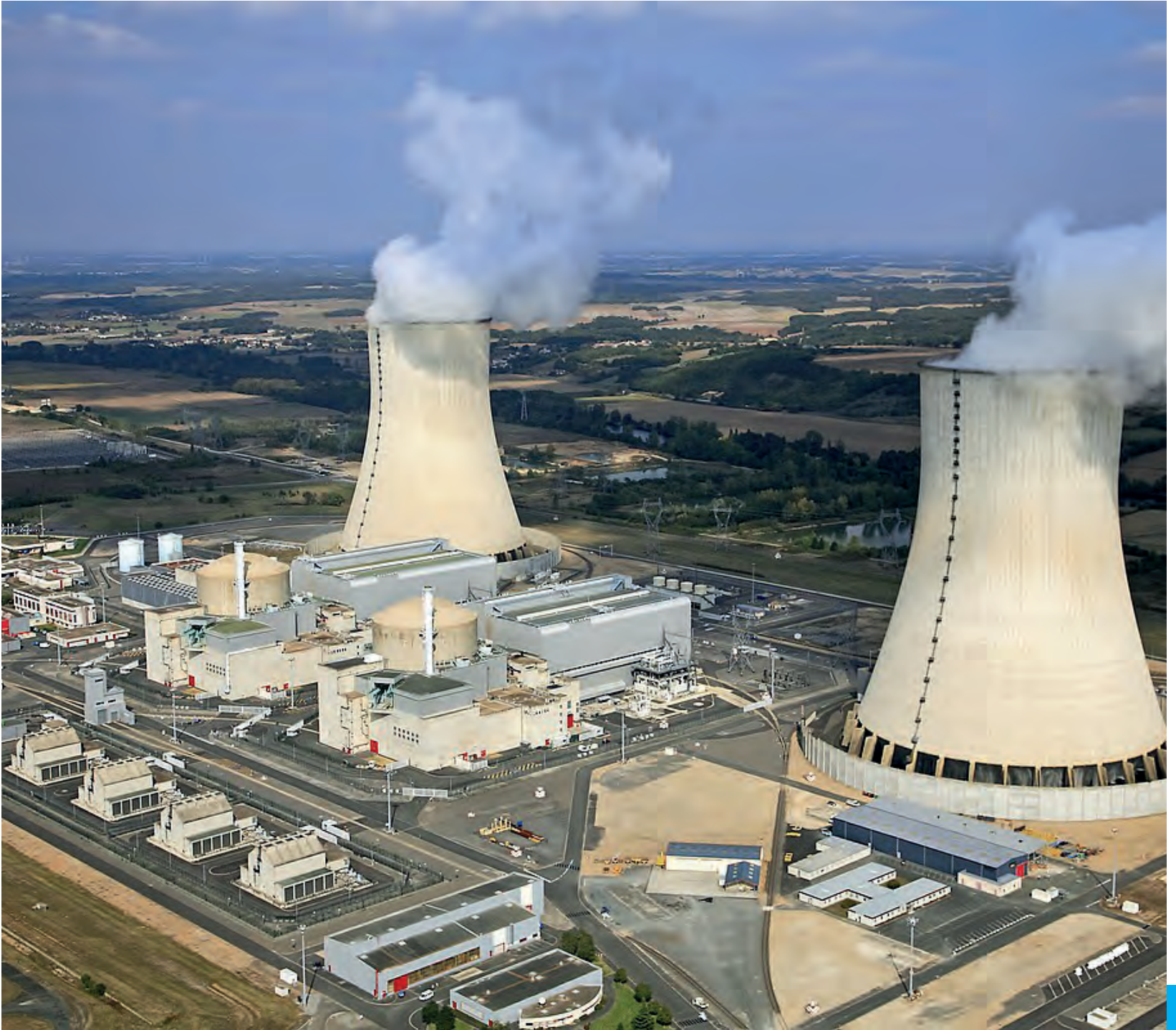
Centrale de Civaux - Une source froide spécifique
