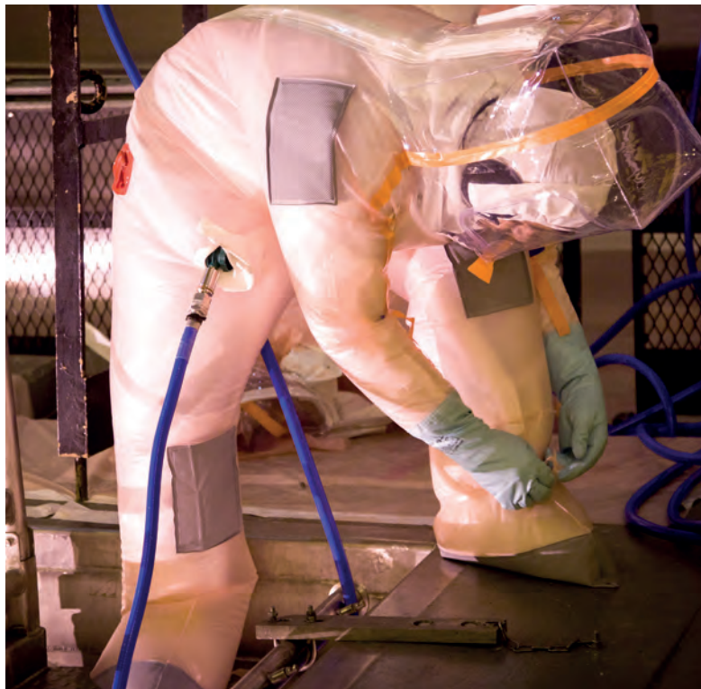
Centrale de Cattenom Intervention zone contrôlée en tenue étanche ventilée
