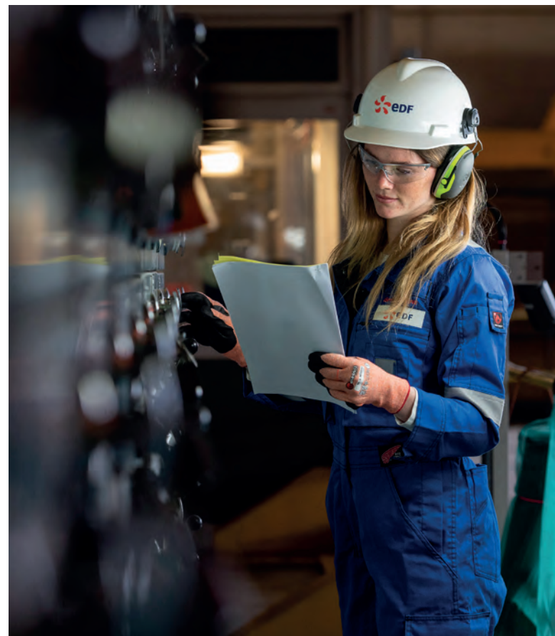
Centrale de Hinkley Point B - Ronde conduite
