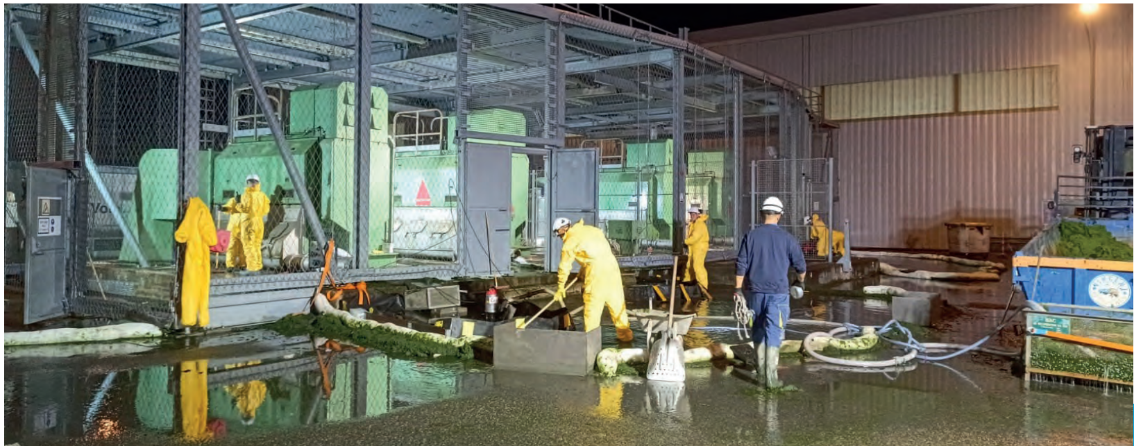
Centrale de Chinon - Nettoyage des filtres à chaîne
