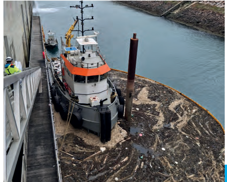
Centrale de Flamanville 3 Nettoyage d'une nappe de débris dans le chenal
