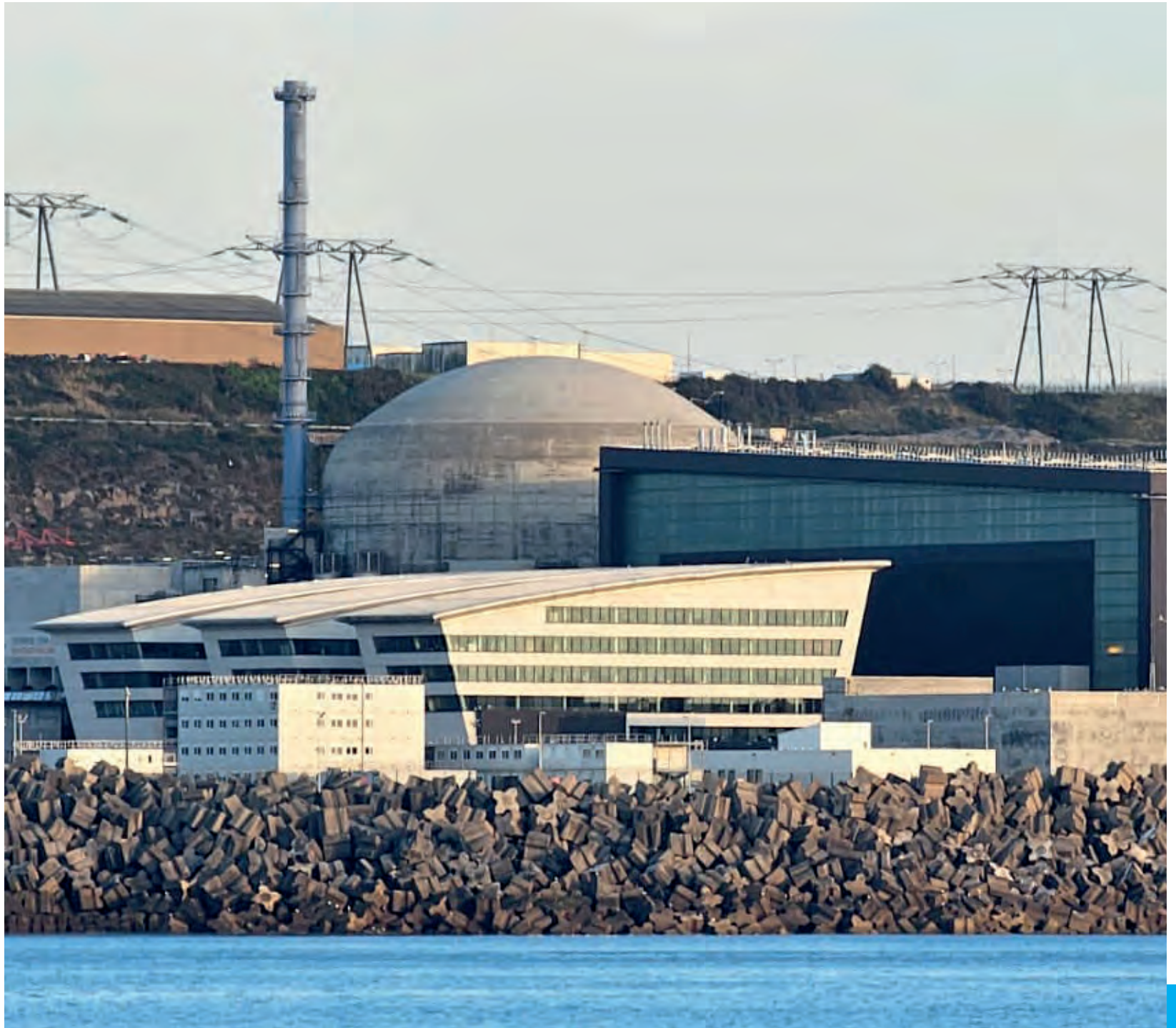
Centrale de Flamanville 3
