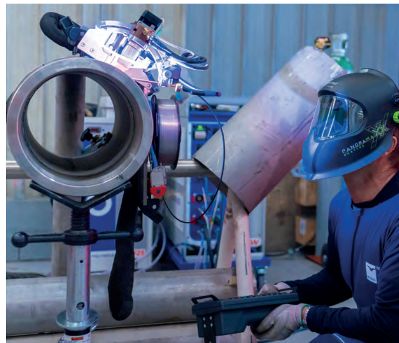
Centrale de Cattenom - Soudage automatique en pré-fabrication
