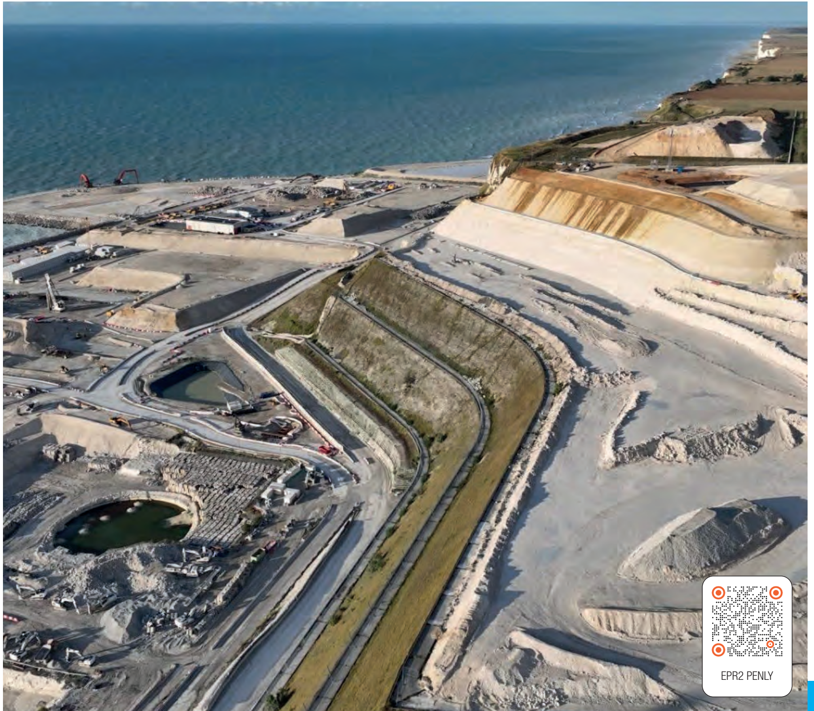
EPR2 Penly - Travaux de terrassement
