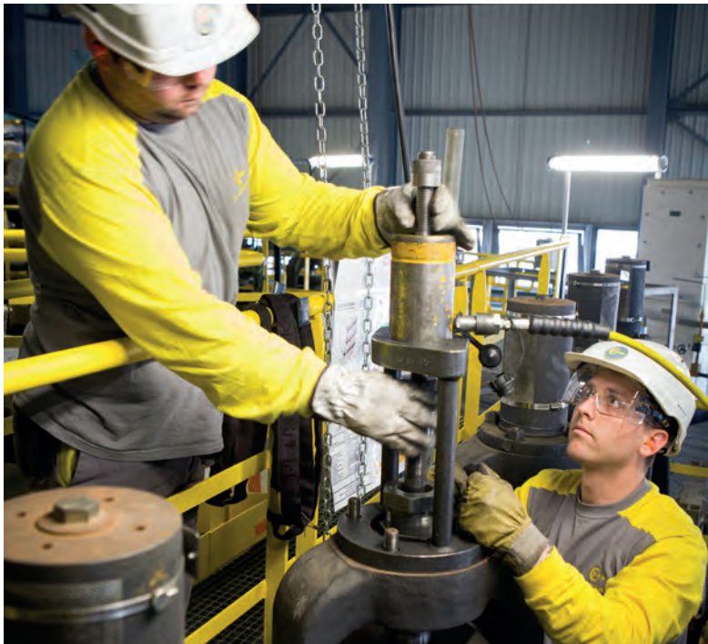
Centrale de Cattenom - Intervention sur une vanne vapeur
