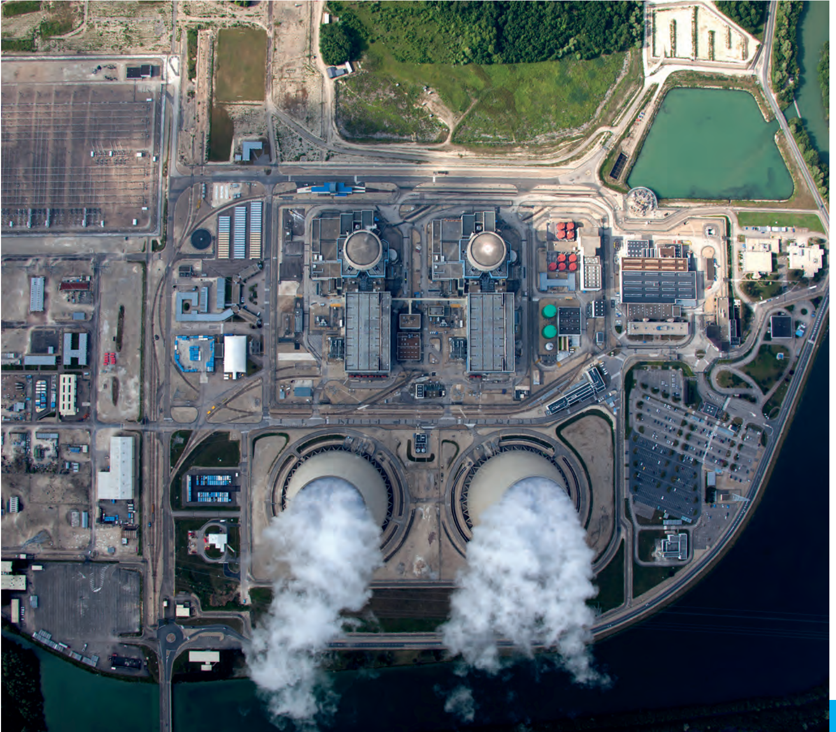
Centrale de Nogent-sur-Seine
