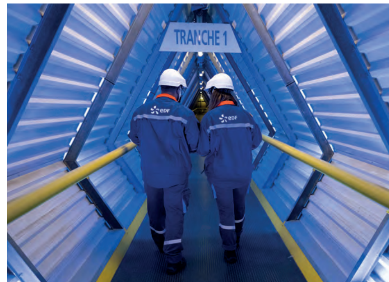
Centrale de Golfech - Accès aux installations industrielles
