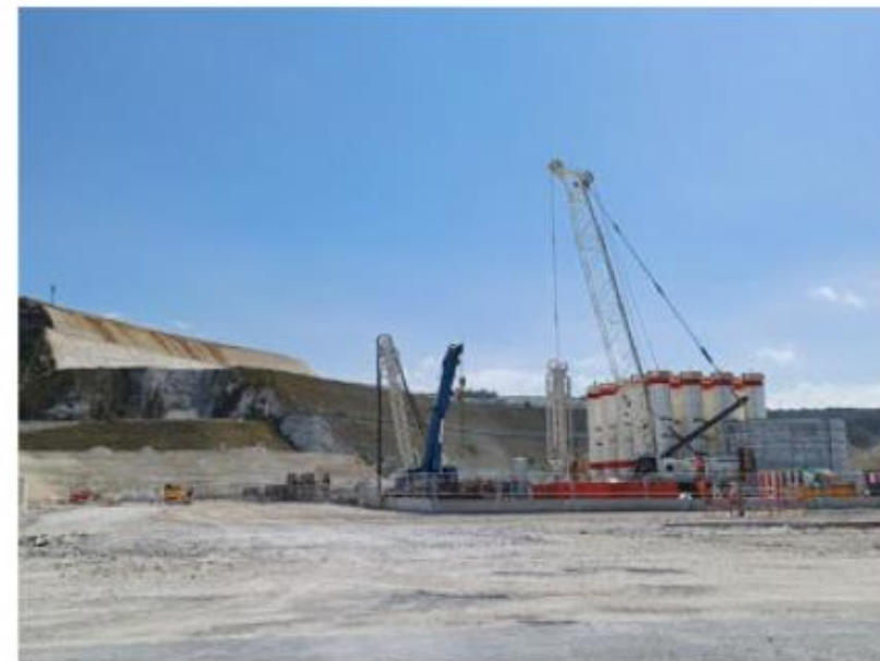
Installation d'une paroi étanche
