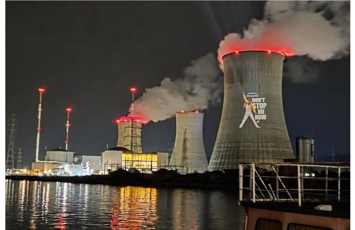
Centrale nucléaire de Tihange (Belgique)
